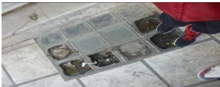
Φωτογραφία 1: Το κορίτσι της ομάδας εκπαιδευομένων φωτογραφίζει έναν από τους κινδύνους που κρύβουν τα πεζοδρόμια –σπασμένα ναλότουβλα φωτοαγωγού πεζοδρομίου.
