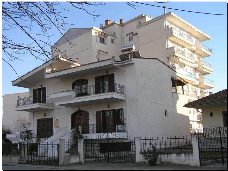
Εικόνα 4. Στο νότιο όριο ενός διωρόφου κτιρίου κτίστηκε ένα εξαώροφο κτίριο με συνέπεια την σκίαση του πρώτου τις περισσότερες ώρες της ημέρας (περιοχή Σιδηροδρομικού Σταθμού). (πηγή: Κωνσταντινίδου Ελισάβετ)
