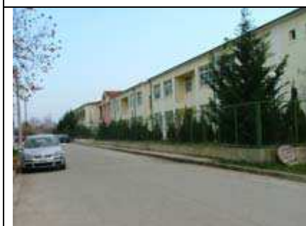
Εικόνα 1.19. Βόρεια πλευρά κτηρίου γ (πηγή : Διπλωματική ΕΑΠ –Συμεωνίδου Παναγιώτα,2008)
