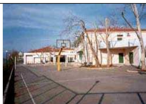
Εικόνα 1.24. Νότια αυλή –ανατολική πλευρά κτηρίου β (πηγή : Διπλωματική ΕΑΠ –Συμμεωνίδου Παναγιώ- τα,2008)
