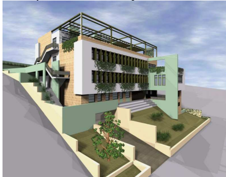
Εικόνα 2.1.Εξωτερικά κατακόρυφα σκίαστρα σε σχολικό κτήριο
