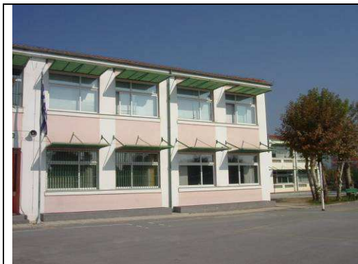
Εικόνα 1.27. Οριζόντια σκίαστρα σε παράθυρα του κτηρίου β –Νότια έκθεση (πηγή :Προσωπικό αρχείο Α.Πασχαλίδου) (01/11/2011)
