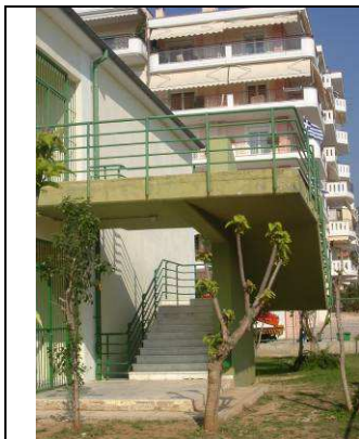
Εικόνα 1.33. Εξωτερική σκάλα κινδύνου-Ανατολική πλευρά κτηρίου α (πηγή :Προσωπικό αρχείο Α.Πασχαλίδου) (01/11/2011)
