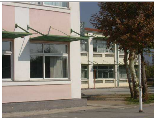
Εικόνα 1.28. Οριζόντια σκίαστρα σε παράθυρα του κτηρίου β –Νότια έκθεση-Λεπτομέρεια (πηγή :Προσωπικό αρχείο Α.Πασχαλίδου) (01/11/2011)
