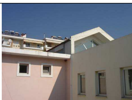
Εικόνα 1.36. Υπερυψωμένο αίθριο κεντρικής εισόδου –κτήριο α (πηγή :Προσωπικό αρχείο Α.Πασχαλίδου) (01/11/2011)
