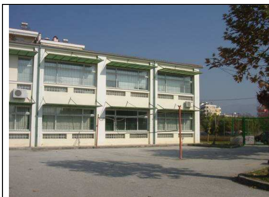
Εικόνα 1.29. Οριζόντια σκίαστρα σε παράθυρα του κτηρίου α –Νότια έκθεση (πηγή :Προσωπικό αρχείο Α.Πασχαλίδου) (01/11/2011)
