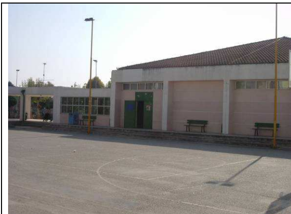
Εικόνα 1.51. Ασφαλτόστρωση στην κεντρική αυλή-γήπεδο μπάσκετ. (πηγή :Προσωπικό αρχείο Α.Πασχαλίδου) (01/11/2011)
