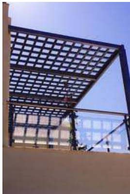
Εικόνα 2.3.Σκίαση με πέργκολα σε δώμα κτηρίου
