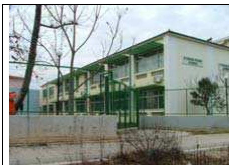
Εικόνα 1.21. Νότια πλευρά κτηρίου γ (πηγή : Διπλωματική ΕΑΠ –Συμμεωνίδου Παναγιώτα,2008)
