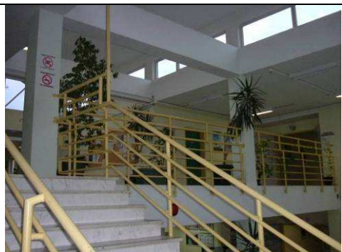
Εικόνα 1.8. Κλιμακοστάσιο κεντρικής εισόδου διακρίνονται οι φεγγίτες στο αίθριο.(κτήριο α) (πηγή :Προσωπικό αρχείο Α.Πασχαλίδου) (21/10/2011)
