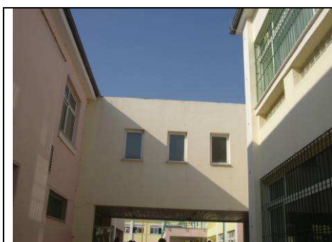
Εικόνα 1.35.Το αίθριο- γέφυρα με παράθυρα εντεύθεν ανατολικά και δυτικά. (πηγή :Προσωπικό αρχείο Α.Πασχαλίδου) (01/11/2011)
