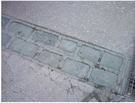
Εικόνα 2.7. Δάπεδο με κυβόλιθο γρανίνη σε αρμούς και έγχρωμο σκυρόδεμα. (πηγή : Α. Πασχαλίδου)
